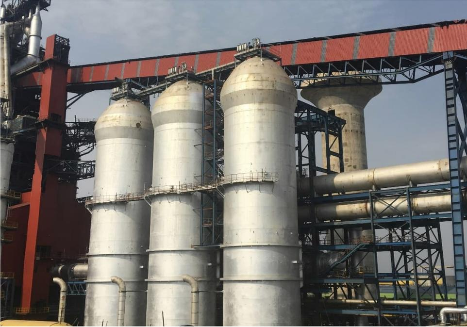
建在印度的普锐特冶金技术内燃式热风炉。
