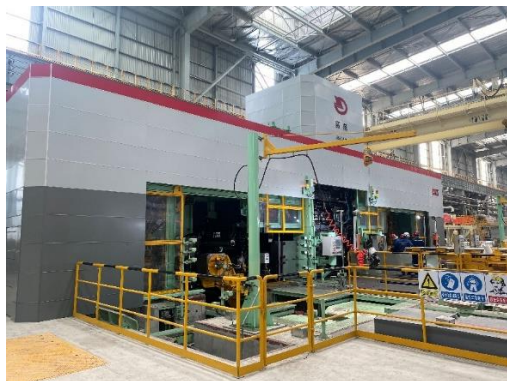
HZ ミル（プライメタルズ テクノロジーズ製）が LY Steel でファーストコイルを生産
