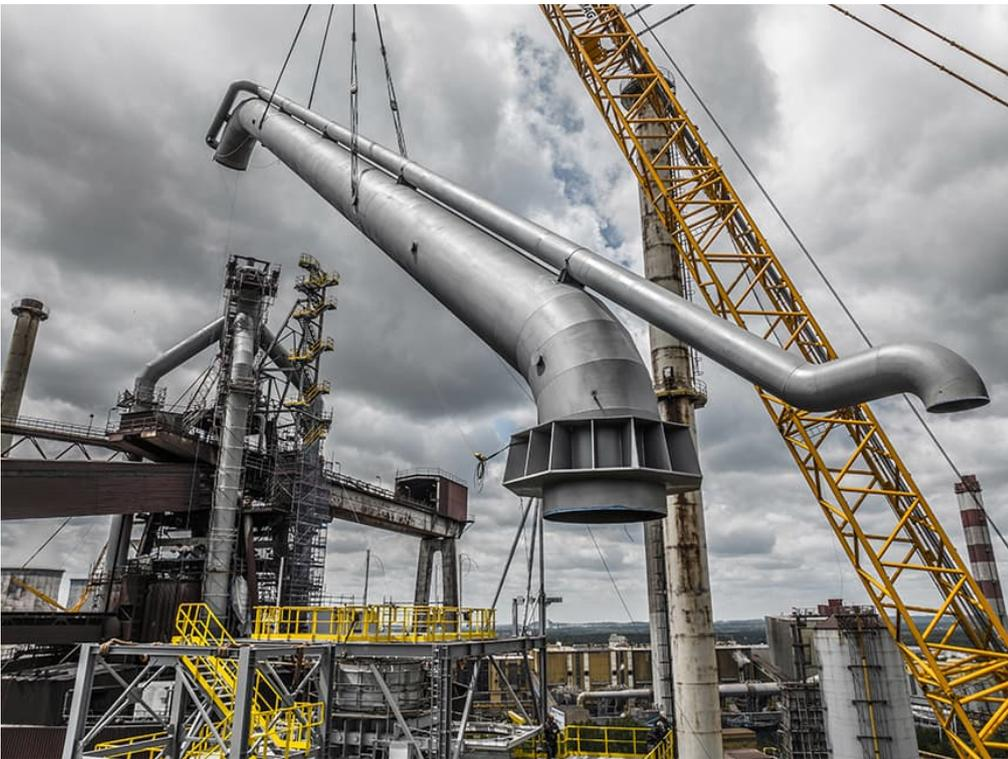
Bau der Gasreinigungsanlage von Primetals Technologies - ein 1000-Tonnen-Kran hebt das letzte Stück der herabgehenden Leitung in Position.
