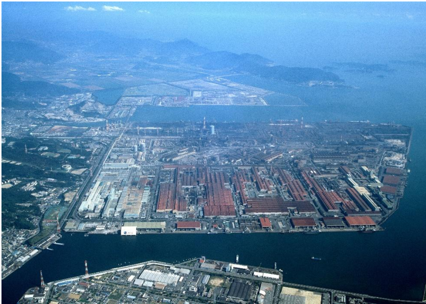
JFE スチール西日本製鉄所（福山地区）全景
