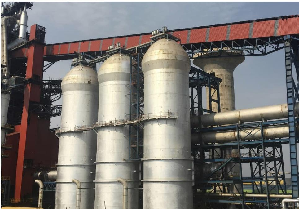
Воздухонагреватели с внутренней камерой горения от Primetals Technologies, установленные в Индии.
