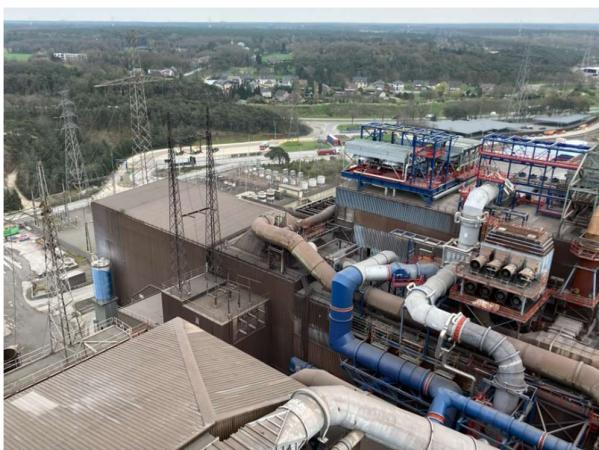
Blick auf die Entstaubungsanlage bei Aperam Genk, realisiert von Primetals Technologies.
