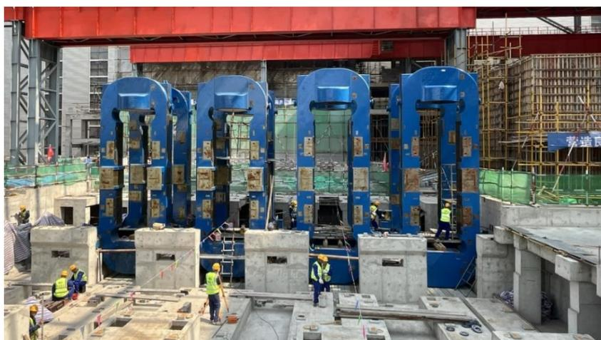
本工事スケジュールの前例のない迅速さを示す、高圧下圧延機 4 基すべての据付
