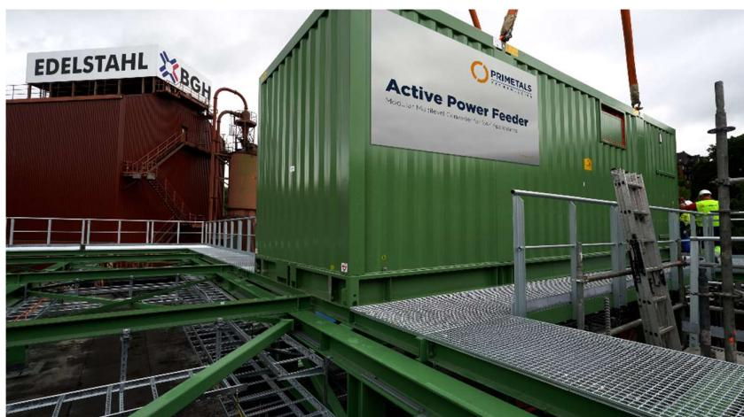
На предприятии BGH Edelstahl введена в эксплуатацию система электропитания Active Power Feeder от Primetals Technologies, обеспечивающая стабильную работу в электросети.
