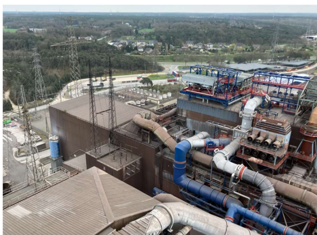
普锐特冶金技术为 Aperam Genk 厂安装的烟气净化系统。
