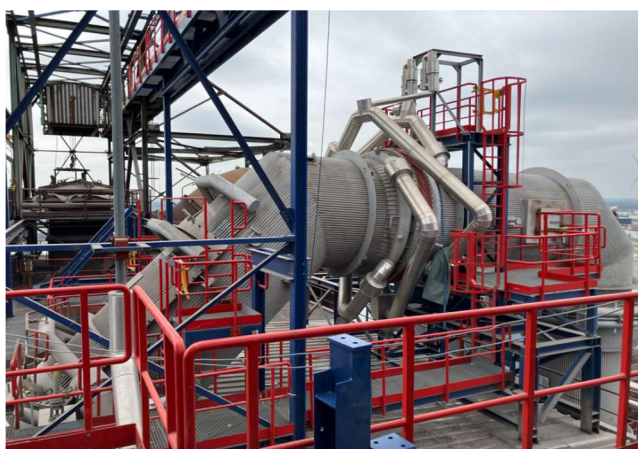
普锐特冶金技术为 Aperam Genk 厂安装的余热回收系统的局部。
