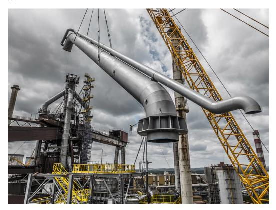
Монтаж установки газоочистки от Primetals Technologies: 1000-тонный кран поднимает на нужную позицию окончательный элемент нисходящей трубы.
