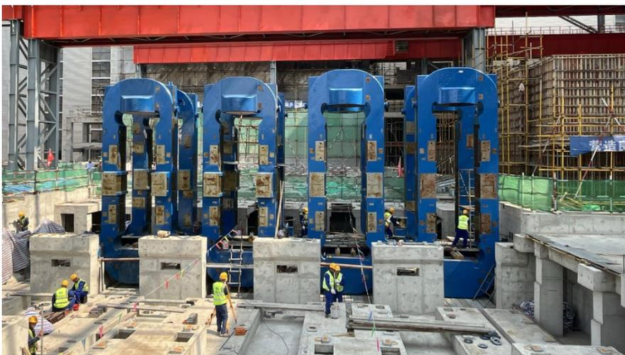
Todas as quatro cadeiras de laminação de alta redução foram instaladas na usina como parte de um cronograma de projeto executado em tempo recorde.
