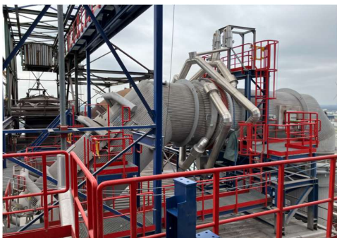
Элемент системы рекуперации тепла отходящих газов от компании Primetals Technologies на предприятии Aperam Genk
