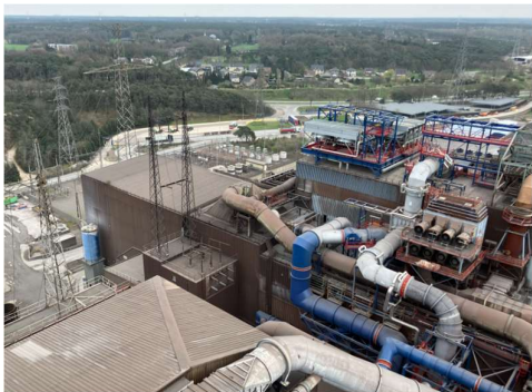
Вид на систему очистки отходящих газов на предприятии Aperam Genk, реализованную компанией Primetals Technologies
