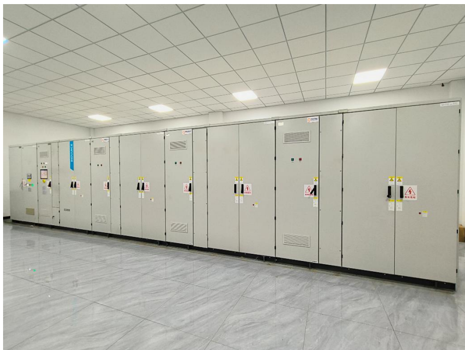
プライメタルズ テクノロジーズと Inovance の提携で供給された中電圧ドライブシステム
