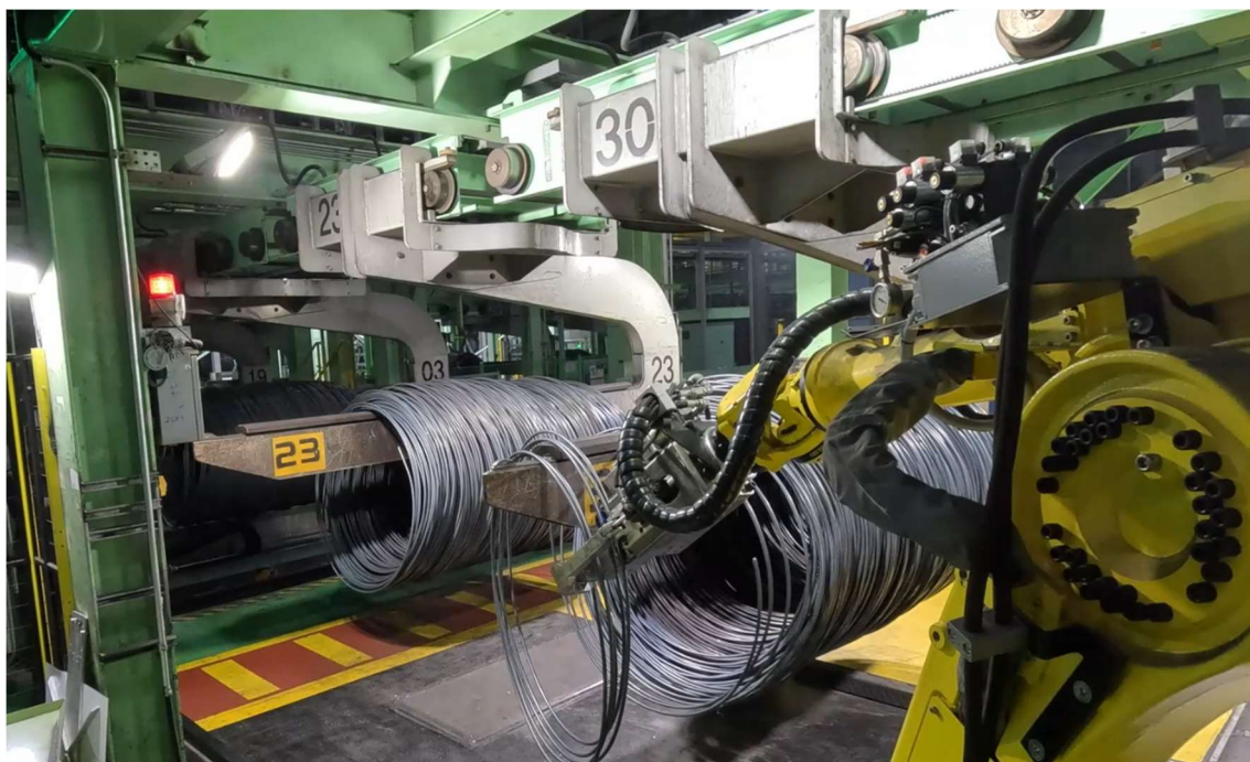
Robô TrimRob da Primetals Technologies para a amostragem e aparação autônomas de bobina
