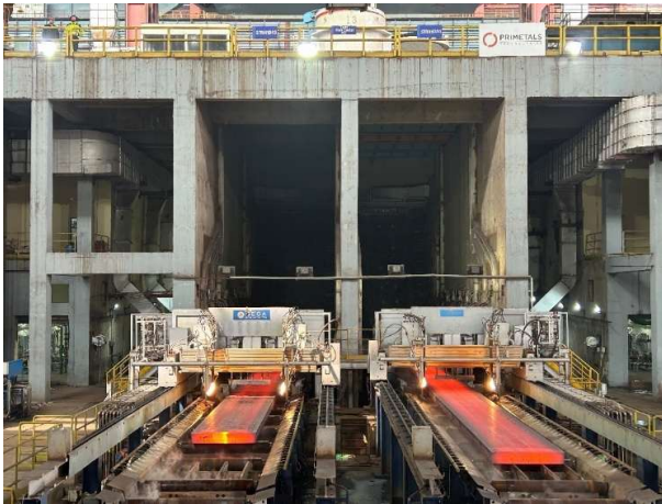
Eine der beiden 2-strängigen Gießmaschinen bei JVML in Toranagallu.
